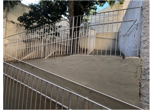
Acesso a Quadra
