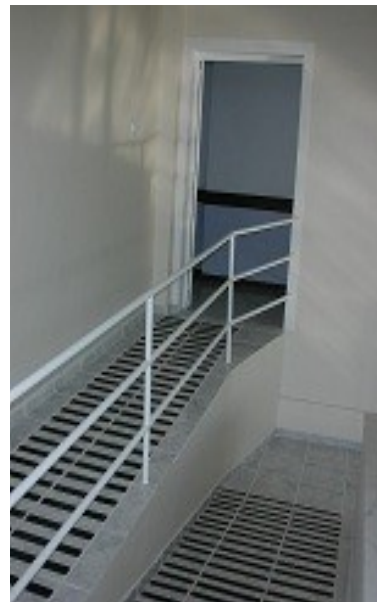
Rampa de acesso ao Espaço Multiuso
